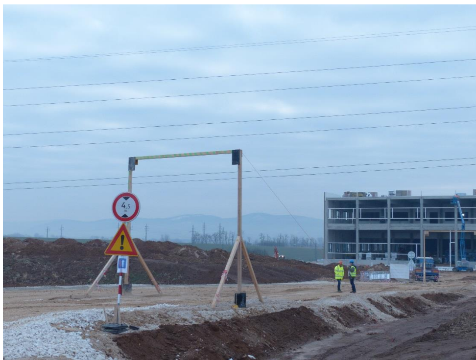
Příklad brány a výstražných značek na staveništi jako ochrana vzdušného vedení proti vjezdu nákladních automobilů se zdviženou korbou a jiných vysokých technických vozidel, kterou vyžaduje jako podmínku pro realizace ZSE Západoslovenská distribučná, a.s.
